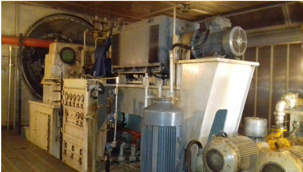
Figure III.7: Moteur qui entraîne une pompe de l'eau de refroidissement d'une turbine à gaz type 9001E
